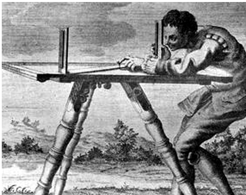
Le operazioni di misura vennero condotte facendo uso principalmente della tavoletta pretoriana
